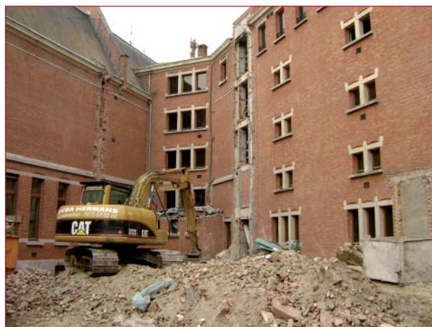
Les travaux aux Archives de l'État à Anvers
