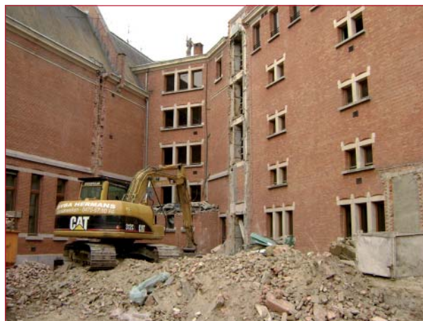
Die Arbeiten am Staatsarchiv in Antwerpen
